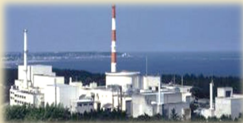
高速実験炉「常陽」
